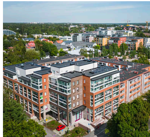
As Oy Vantaan Peltolan Tähti, johon asennettiin aurinkopaneelit vuonna 2022
